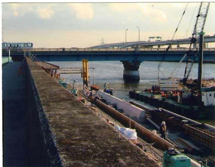
葛西橋東詰付近の中川堤防耐震工事（3月20日撮影）
