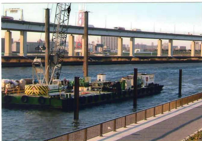
旧葛西橋東詰付近の工事風景。ここは河川テラスも完成(3月20日撮影)
